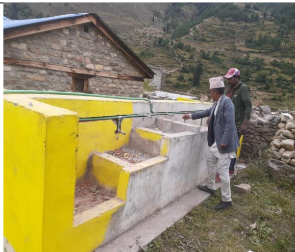
पाइपलाइनधारा निर्माणको क्रममा
